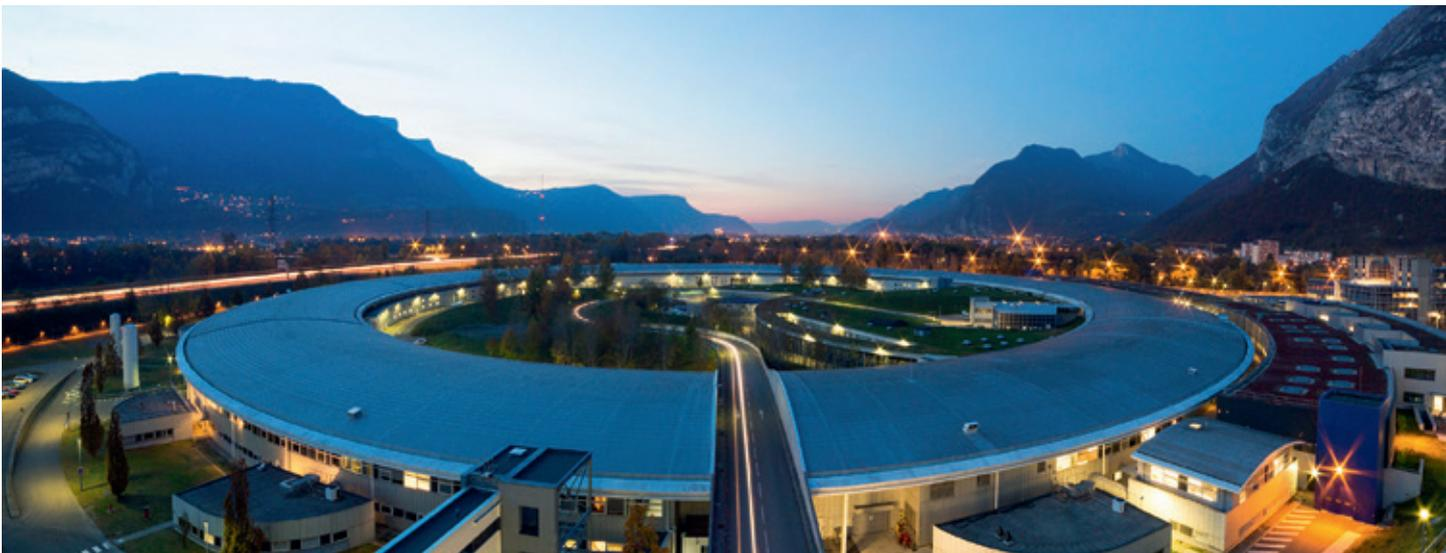
Die ESRF in Grenoble: Der neue Elektronenspeicherring der 4. Generation ist innerhalb des ringförmigen Gebäudes mit ca. 1 km Umfang untergebracht. Er versorgt 40 Beamlines gleichzeitig mit Synchrotronstrahlung, eine davon ist die vom HZDR entwickelte und im User-Modus betriebene ROBL-II.
